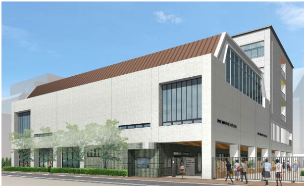
校舎外観(北側)
