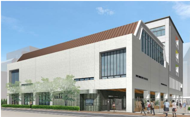
校舎外観(北側)
